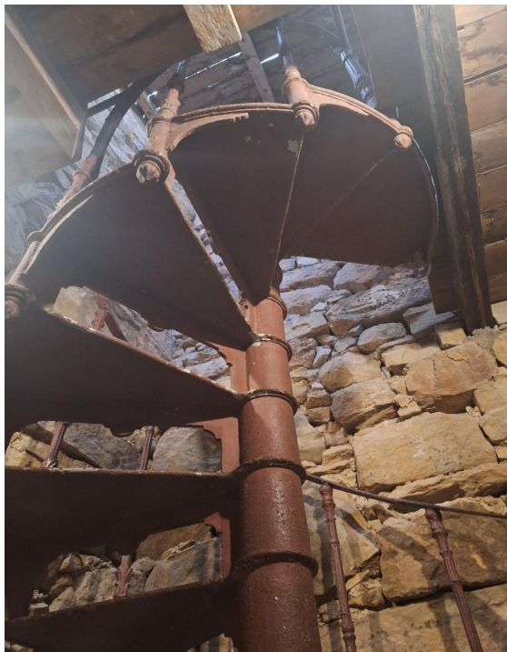
Escada que dá acesso à torre da Igreja Nossa Senhora da Assunção, Igreja Matriz de Viçosa do Ceará - CE, 2023. (Acervo do autor)
