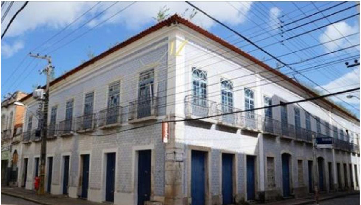
Figura 03: Palácio das Luzes, casa de Ana Jansen, no Centro de São Luís.
