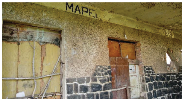
Imagem 3 - Ruínas da Estação Mapele
